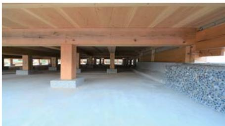
基礎と上部構造を緊結しない石場建て工法
