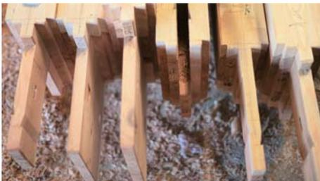
大工の手刻みによる仕口と継手
